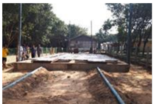
工事内容 【海外事業】 排水処理指導 （ミャンマーにて）
